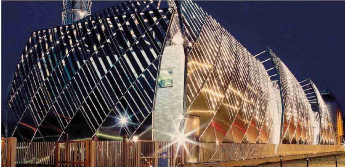
Svolta hi tech per Iren. Gli accumulatori di calore del Politecnico di Torino
